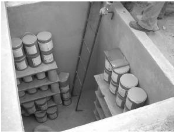
Figura 6 – Vista del depósito subterráneo La Troya con los contenedores con material arqueológico de tamaño muy pequeño. A la derecha cierre del depósito con la colocación de tapas de hierro y hormigón.
